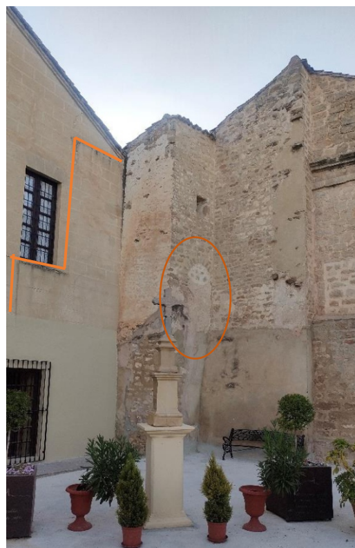
Interior del torreón en el patio exterior
