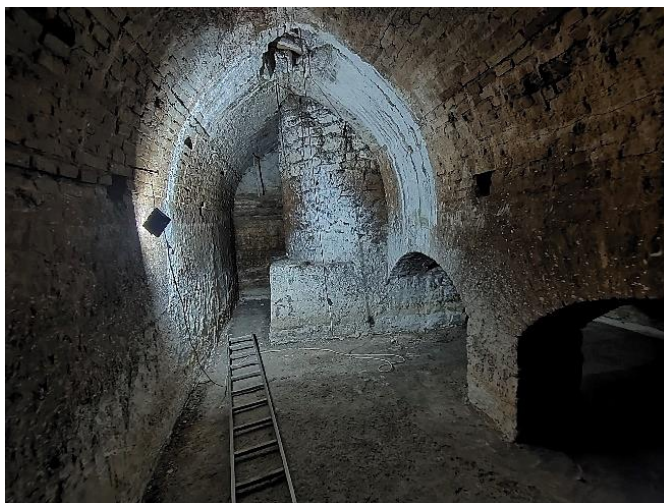
Vista parcial del aljibe, con la base de la columna
